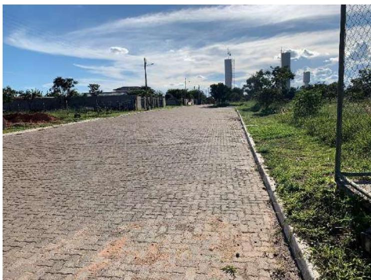
**Figura 3: Via pavimentada com blocos intertravados do Condomínio San Francisco II.**
