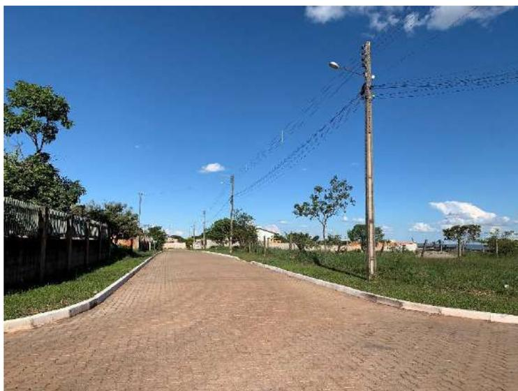
**Figura 4: Via pavimentada com blocos intertravados, sem calçadas, do Condomínio San Francisco II.**
