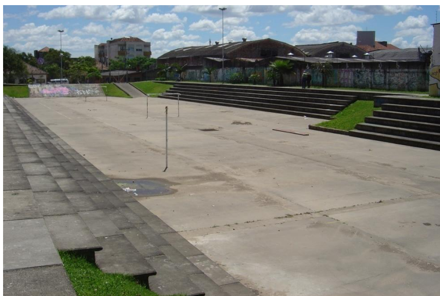
Figura 7.2. Quadra esportiva em uma bacia de detenção em operação na cidade de Porto Alegre/RS.
